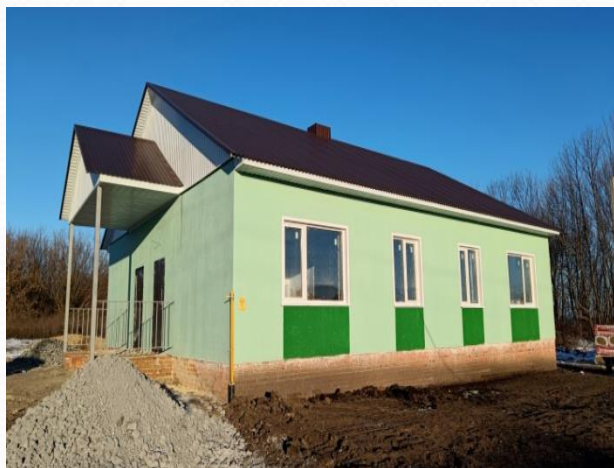
Строительство 4-х квартирного дома в п.Кировский 2022 год
