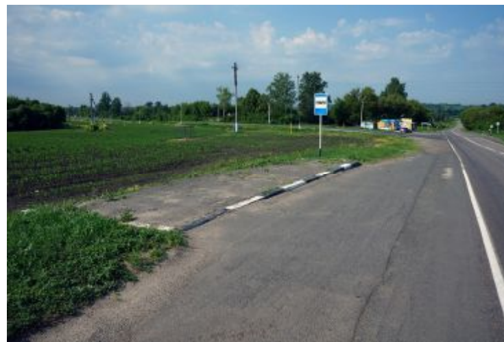
Остановочный пункт ОПТ на дороге Обоянь – Солнцево – Мантурово (11 + 408)
