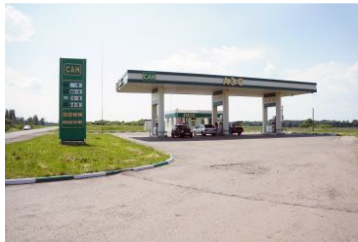
АЗС на дороге Обход Пристени (ул. Объездная) (0 + 468)
