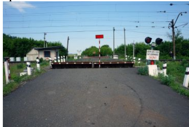
Закрытый ж/д переезд на дороге, соединяющей д. Колбасовку и п. Кировский
